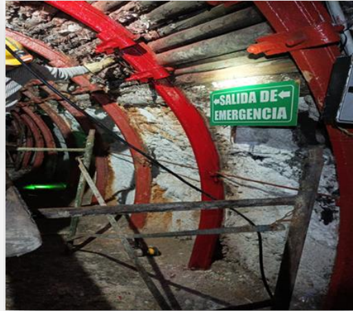
5.1.18 Instalación de Malla en Techo Cámara 9 Norte.
